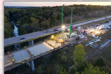
Foto de Clarkson Construcción
